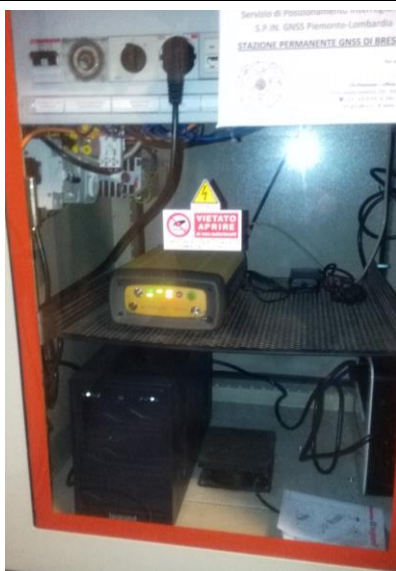
Armadio contenente il ricevitore ed il gruppo UPS
